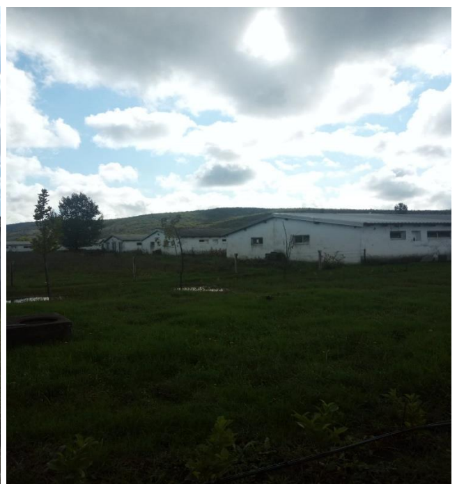
Slika br.2.5 – Detalj sa lokacije
