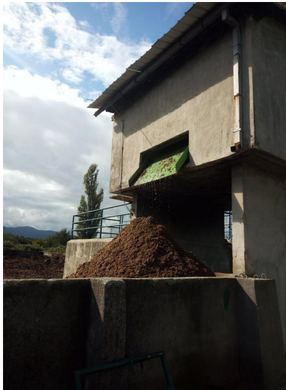
Slika br.3.1- Izdvojeni stajnjak na separatoru
